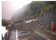
■豪雨による山手崩壊 (国道55号 東洋町)
