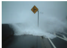
■台風の高波による越波 (国道55号 室戸市)
