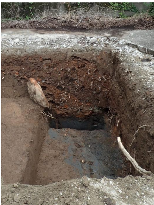
写真2 石組み水路検出状況 (南から)
