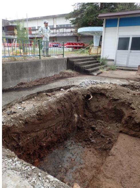
写真1 2トレンチ掘削状況(北西から)
