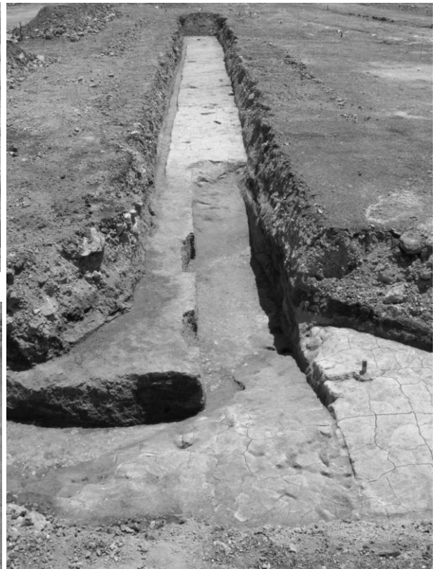
全景 雨水水管部分（北から）
