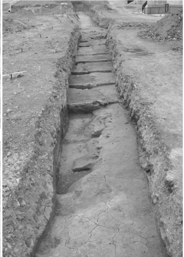
全景 雨水水管部分（東から）
