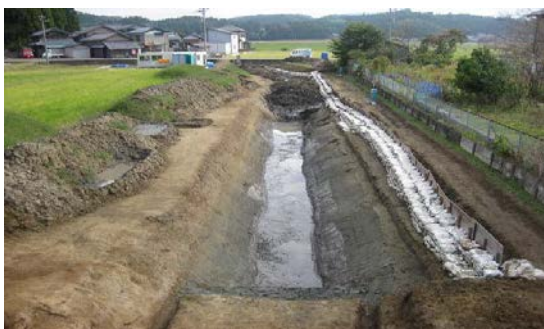
調査区西側完掘状況（西から）
