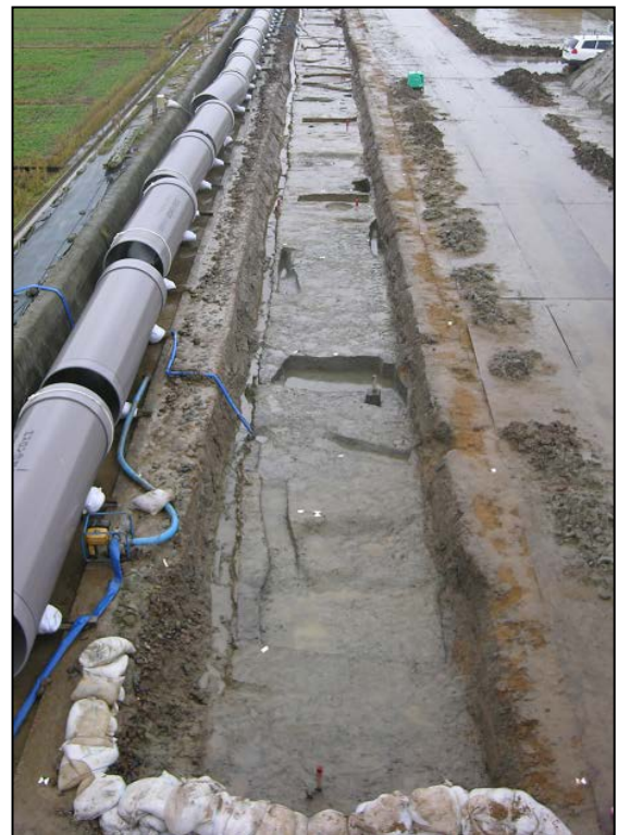
2区北半部北側 (北から)
