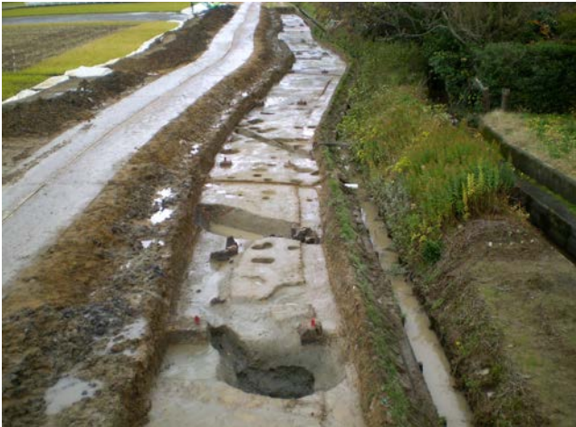
写真1 調査区東半全景 (西より)
