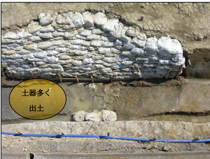
落ち込み 西岸（北から）
