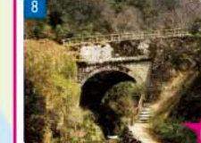
石造りアーチ橋 (桜橋) 明治14年の福井県誕生の後、南北と交通を結ぶ最初の事業として「春日野道」が開通されました。1橋はスチール製で、2橋は石造りのアーチ橋で、明治19年(1886年)の開通時に河野川に架けられたもので、北陸地方では珍しいものです。
