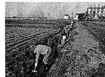
【水路の泥上げ】
