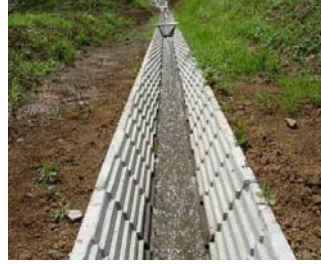
第3図 横断方向スロープ水路
