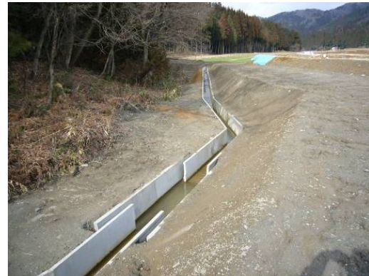
第6図 縦断方向スロープ水路工設置状況
