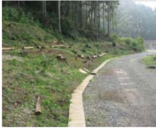
第2図 蓋盤設置水路
