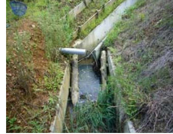
第4図 急流工と縦方向スロープ
