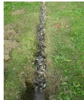
第2図 排水溝に充填した資材
