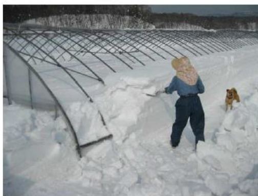
ハウスを覆うぐらいの積雪があった場合、肩部から除雪を始める
