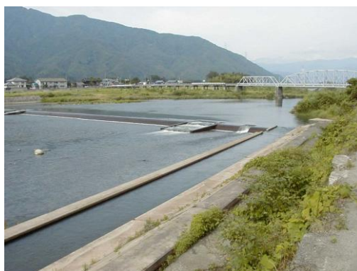
九頭竜川 小舟渡取水堰 (永平寺町藤巻付近)
