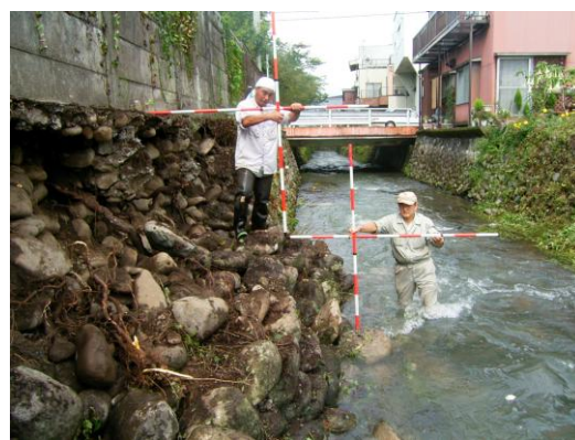
大蓮寺川 護岸被災（勝山市元町）
