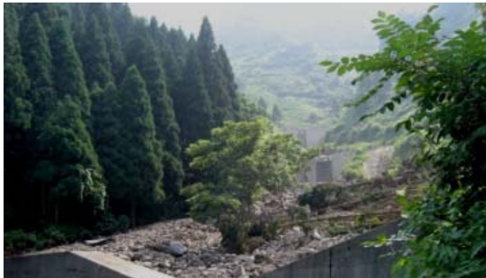
ダム群による流出土砂の抑止（捕捉）状況
