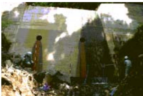
治山施設被災状況（局所洗掘）
