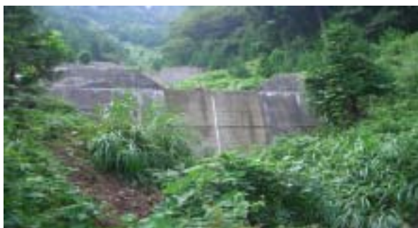
溪床の安定状況 (溪流)
