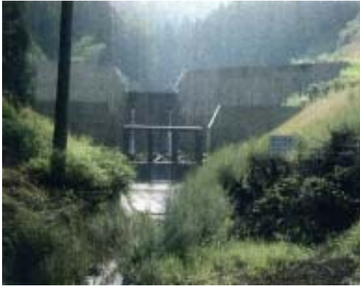
副堤の流木捕捉工による流木の捕捉状況および本堤の堆砂状況 (神宮川 今立町大滝)
