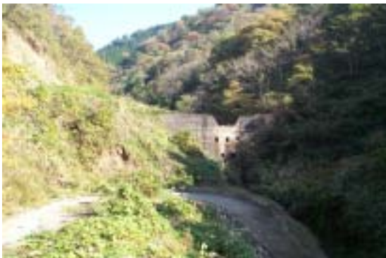
三ツ俣川の不透過型砂防堰堤の効果（推定捕捉量 8,697 ）
