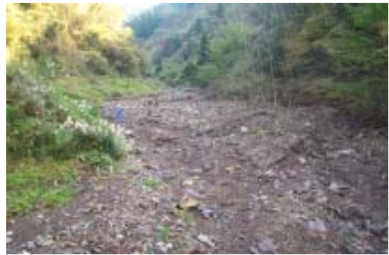
三ツ俣川の不透過型砂防堰堤の効果（推定捕捉量 8,697 ）
