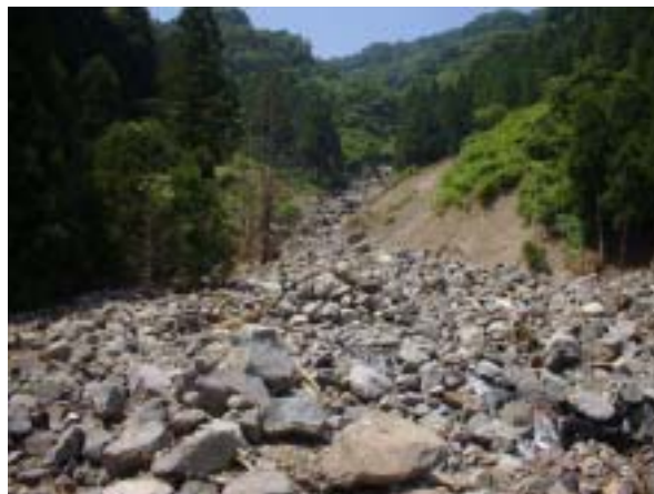
山脚の固定（蔵作6号砂防堰堤）
