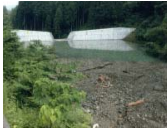
副堤の流木捕捉工による流木の捕捉状況および本堤の堆砂状況 (神宮川 今立町大滝)
