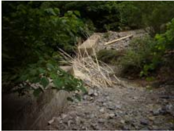
既設砂防堰堤 3 号の土砂捕捉状況
