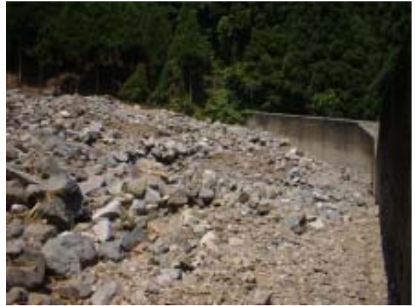
既設砂防堰堤 6 号の土砂捕捉状況
