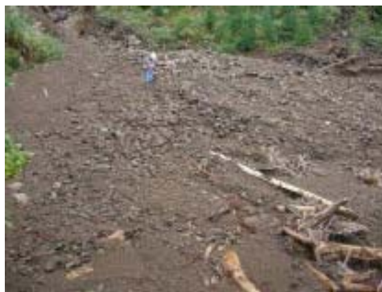
透過型砂防堰堤の土砂・流木捕捉状況（水間地区）
