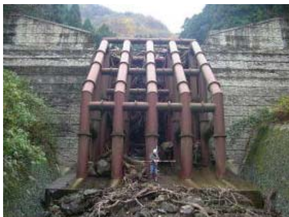
透過型砂防堰堤の土砂・流木捕捉状況（水間地区）
