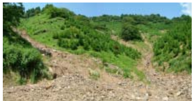
溪床荒廃状況 (溪流)
