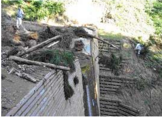
土砂流出抑止状況（山脚の固定）
