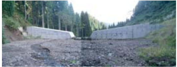
流出土砂捕捉状況
