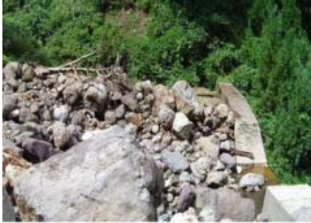
流出土砂の抑止（捕捉）状況 美山町蔵作（上良）
