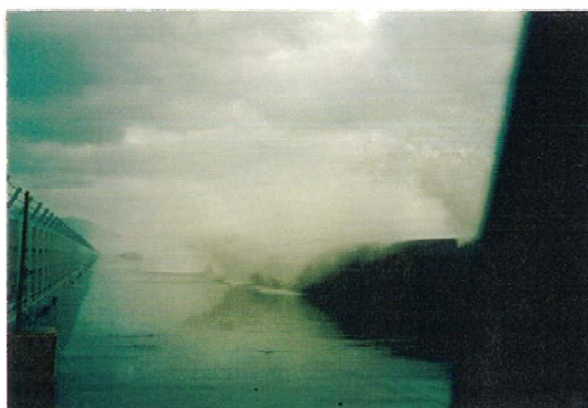
福井港海岸 における越波状況
