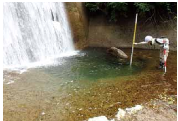
〔砂防堰堤の点検〕
