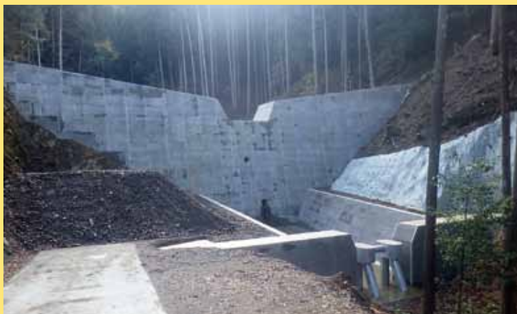
こうだに 〔神谷川砂防堰堤〕 (若狭町神谷) 〔不透過型堰堤〕
