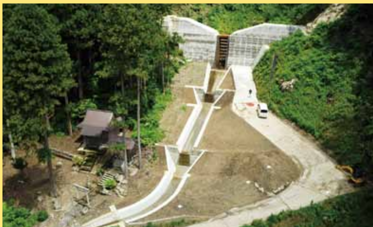
しんめいがたに 〔神明ヶ谷川砂防堰堤〕 (勝山市北郷町東野) 〔透過型堰堤〕
