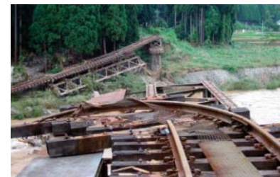
濁流で流されたJR越美北線の鉄橋
