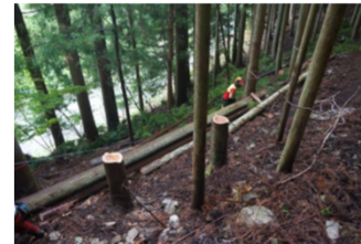
間伐材を利用した簡易落石防止柵
