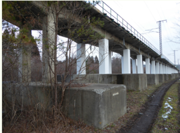
高架橋の耐震補強工事
