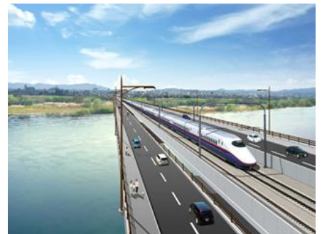
九頭竜川橋りょうのイメージ図 (新幹線と道路の一体橋)
