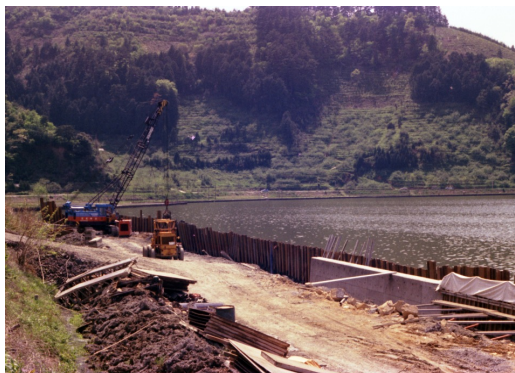
コンクリート護岸工事（昭和 50 年頃）
