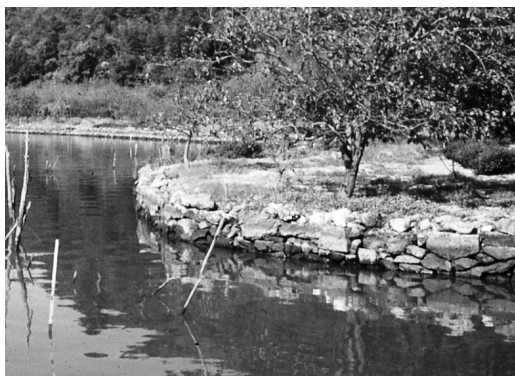
石積み護岸（昭和 50 年頃）
