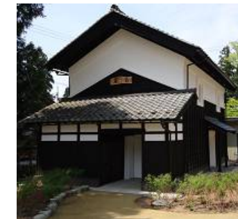
土蔵を誘客施設に改修 [H26. 7 オープン]
