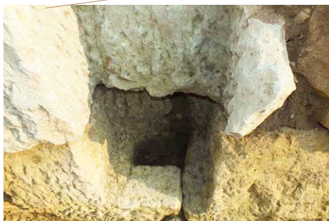
写真 2 支柱筋の南石垣柱痕跡
