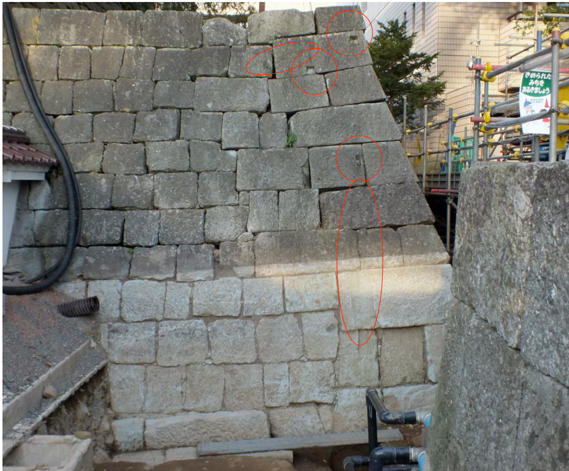
写真 11 檜台石垣西面にのこる脇塀あるいは棟門の屋根痕跡等
