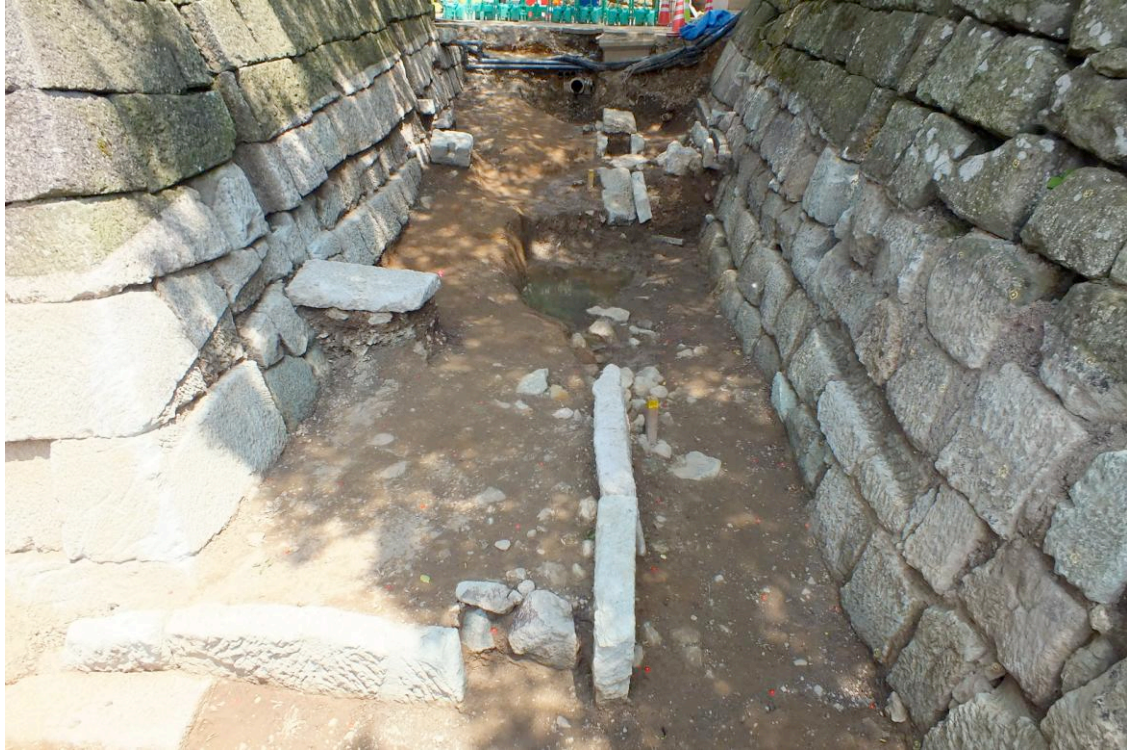
写真 10 笏谷石側溝と石垣面にのこる側溝痕
