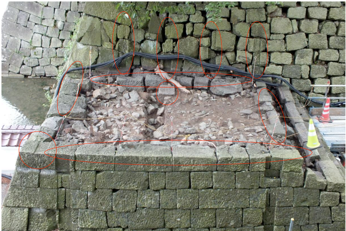
写真 7 櫓台石垣の土台痕・礎石・土台下礎石と天守台石垣の方杖柱痕
