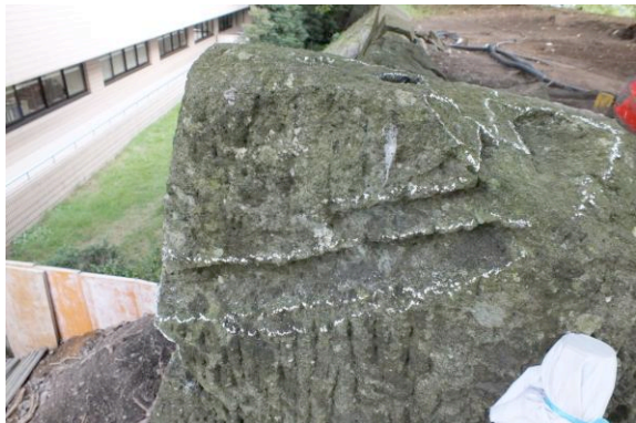
写真 8 石瓦葺の痕跡
