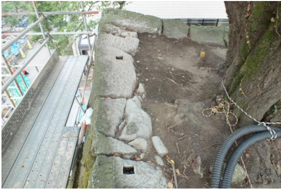
写真 13 南石垣天端にのこる土塀柱痕跡
