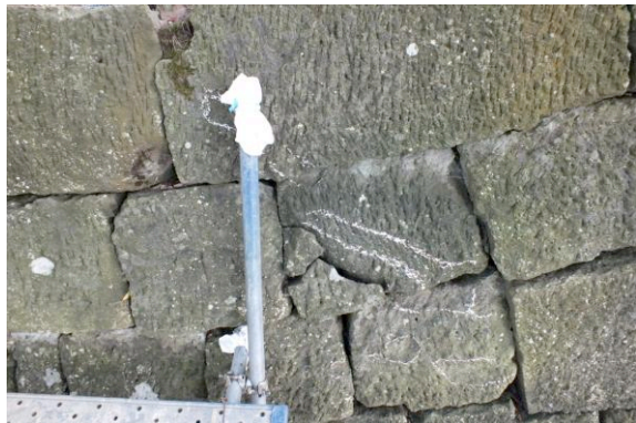
写真 9 屋根葺材の痕跡
