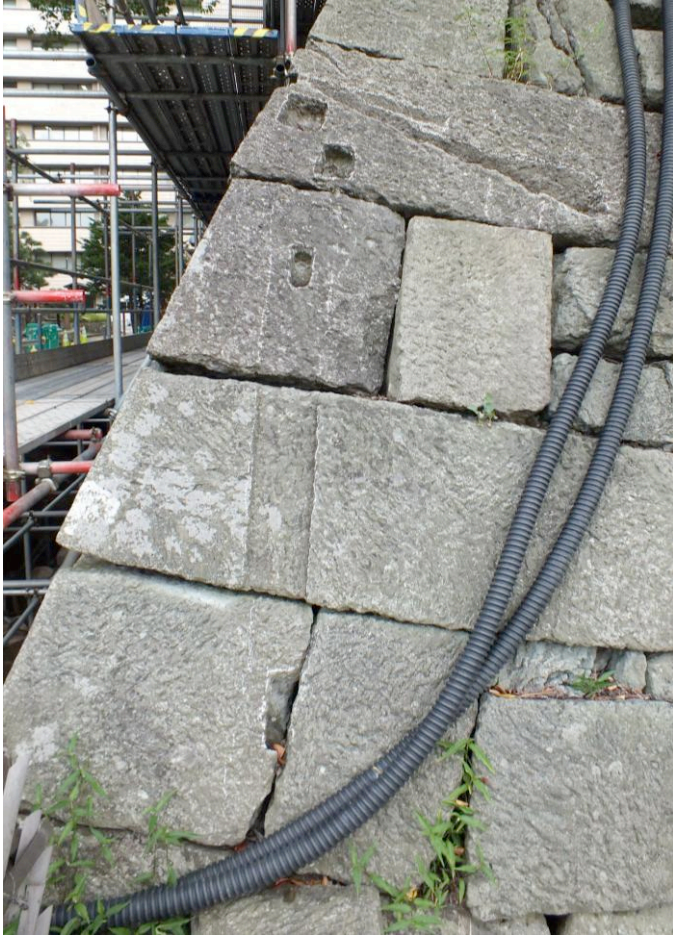
写真 12 南石垣西面にのこる杢形の土塀痕跡
