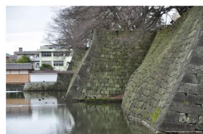
本丸西側の石垣の状況
