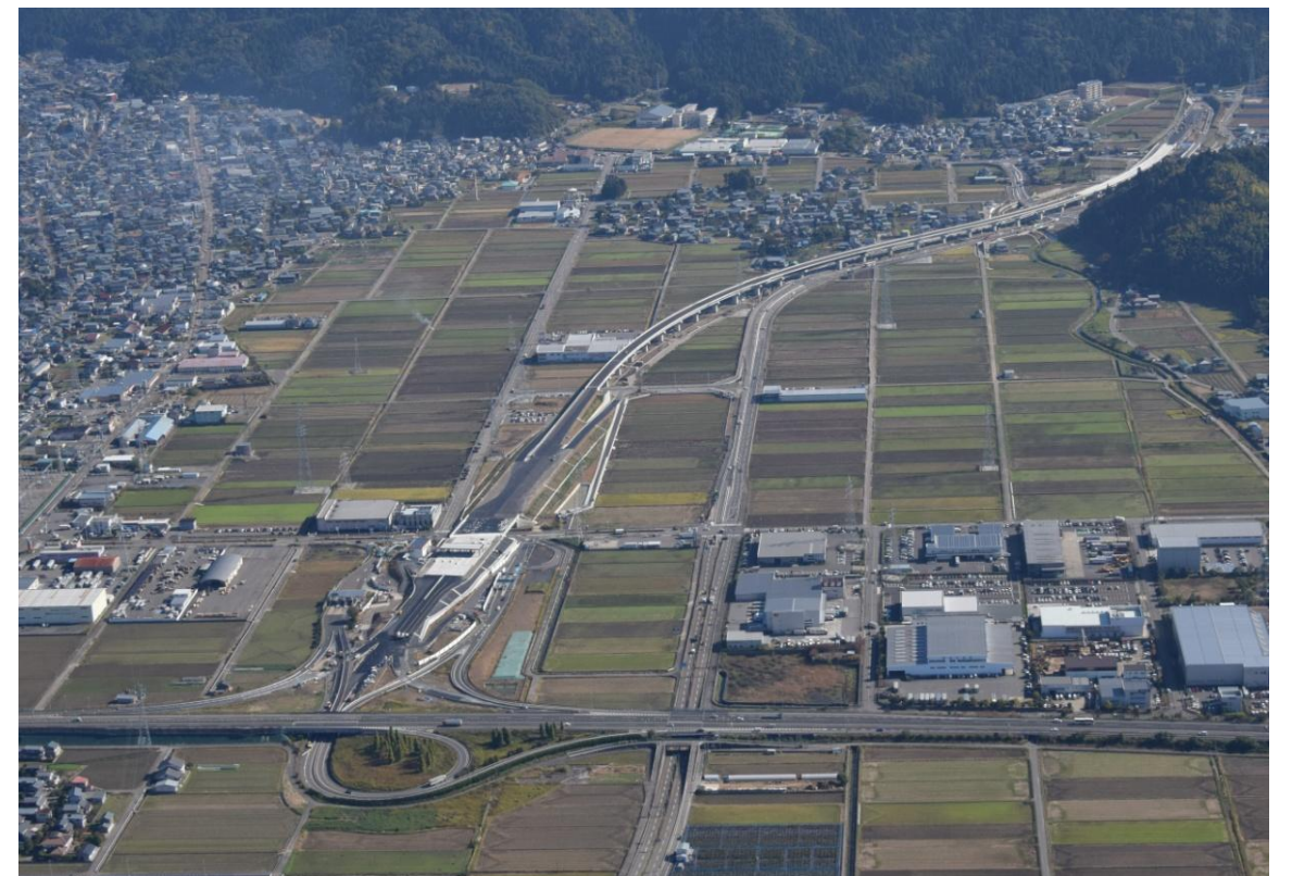
【中部縦貫自動車道 福井北JCT】
