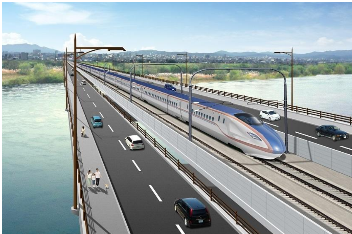
【北陸新幹線 新九頭竜大橋】
