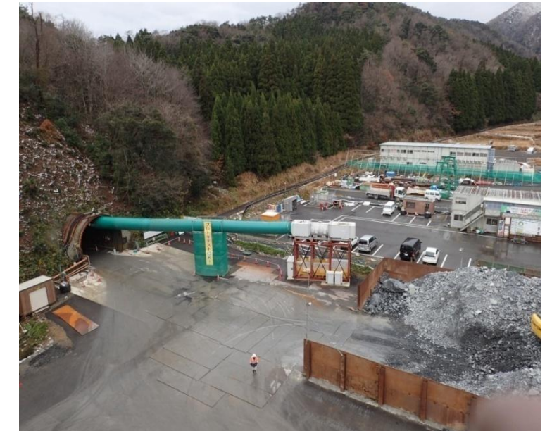
【新北陸トンネル工事(葉原工区)】
