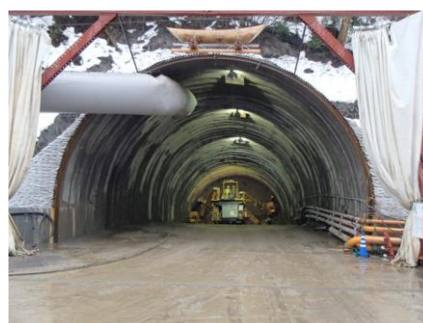
進む北陸トンネルの工事
