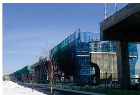
【福井高柳高架橋の工事】
