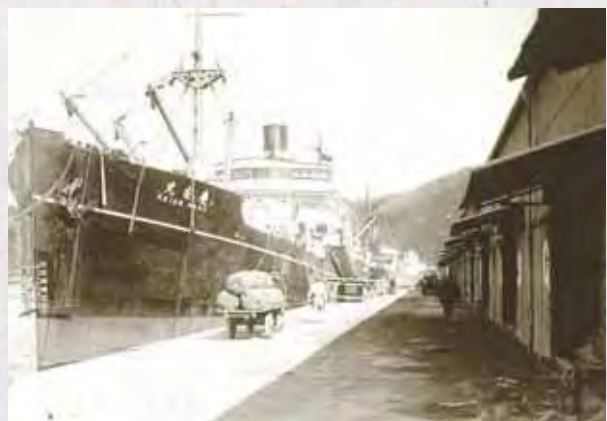
敦賀港新岸壁
