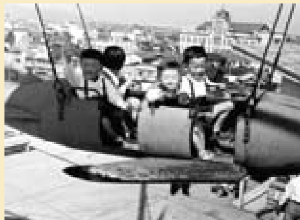
「だるまや」屋上遊園地 昭和31年(1956)
