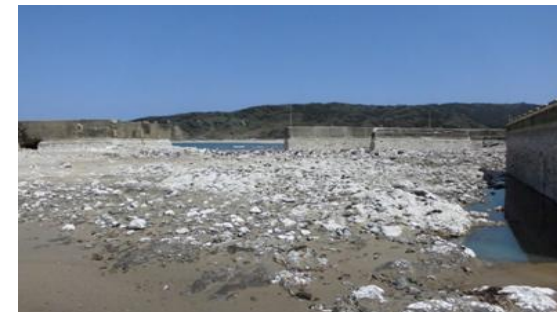
隆起した漁港・海岸黒島漁港 (輪島市)
