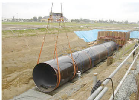
④ 地面を掘って太い管をならべ、つなげる
