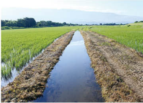
④ 土を掘ってつくった水路 (福井市江上町)
