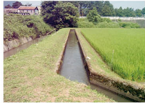
④ コンクリートでできた水路 (大野市稲郷)
