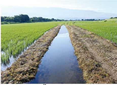
④ 土を掘ってつくった水路 (福井市江上町)
