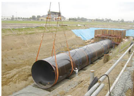
Ⓢ 地面を掘って太い管をならべ、つなげる
