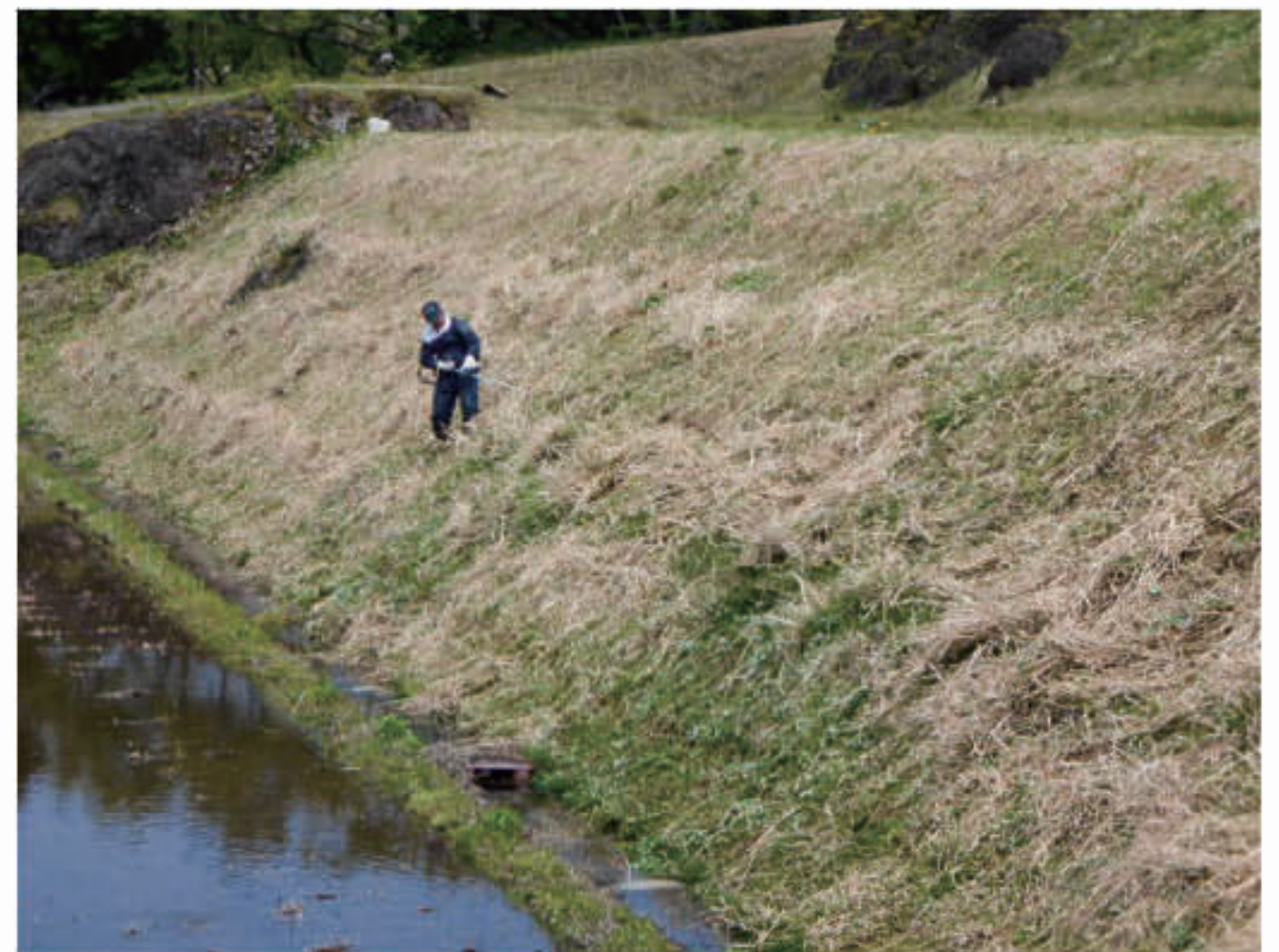
山間地域での水田けいはん法面の草刈り
