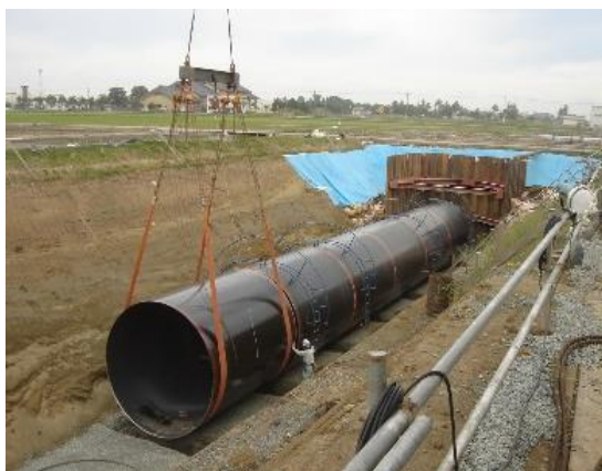
⬇ 地面を掘って太い管をならべ、つなげる
