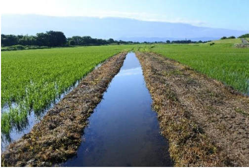
土を掘ってつくった水路 (福井市江上町)
