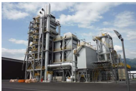
木質バイオマス発電所（大野市）
