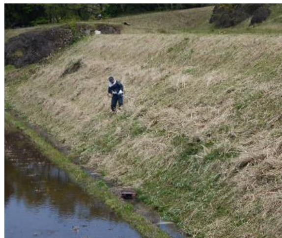
① 山間地域での水田けいはん法面の草刈り
