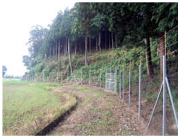
④ 柵の設置
