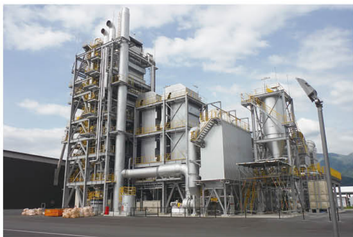
木質バイオマス発電所（大野市）
