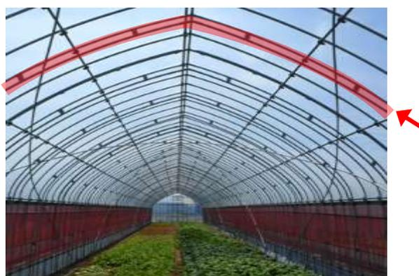
図14 ダブルアーチによる補強
