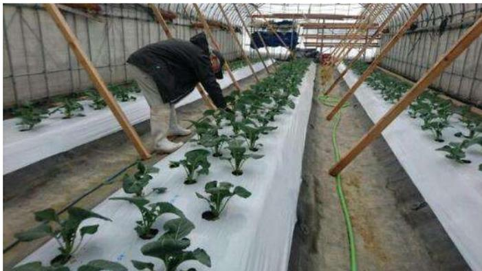
図34 肩部に設置した支柱による補強の様子
