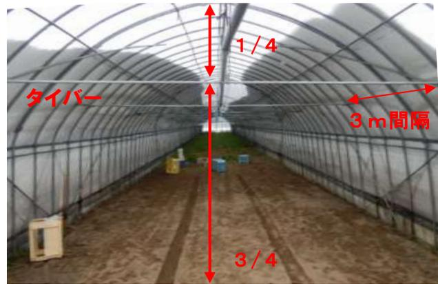
図33 タイバーによる補強
