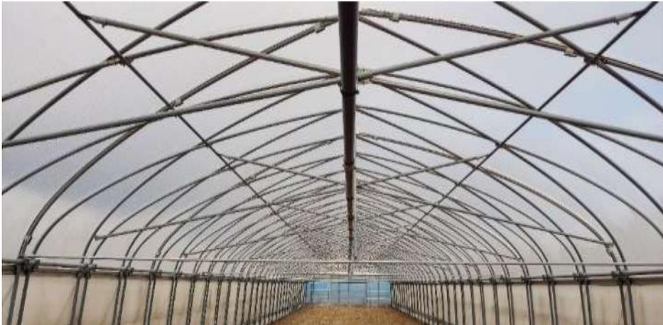
図32 間口 6m、パイプ径 31.8 mm、ピッチ 100 cm、トラス構造、X型斜材補強
