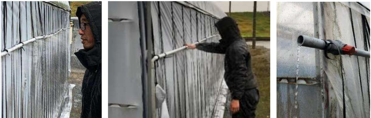
図28 融雪パイプの事前点検(散水して目視確認、ノズル角度調整、パイプ掃除等を行う)
