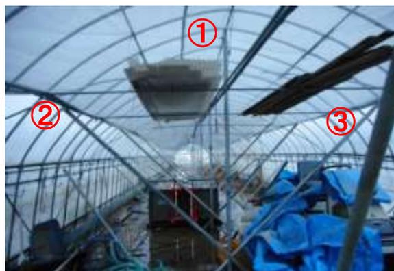
図35 天頂部への中柱①と両肩部への支柱②③による補強(3本方式)
