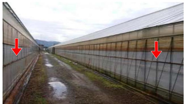
図40 ハウス間隔を広くして融雪パイプ設置
