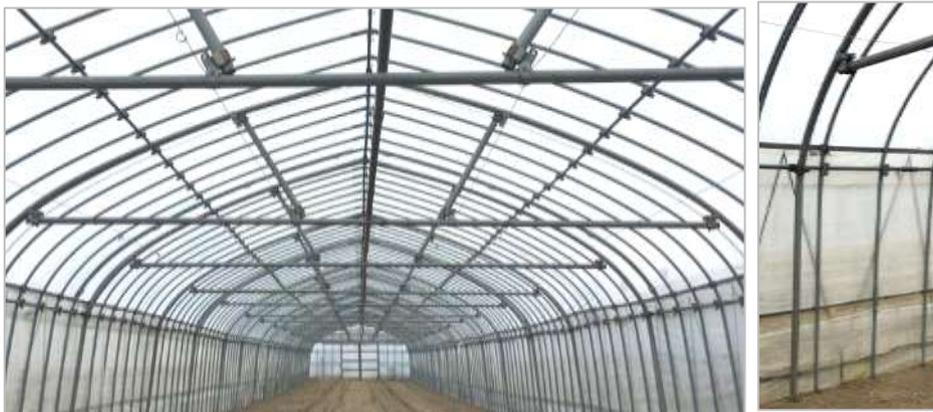
図30 間口 5.4m、パイプ径 25.4 mm、ピッチ 45 cm、パイプ径 42.7 mmのアーチ＋タイバー補強
