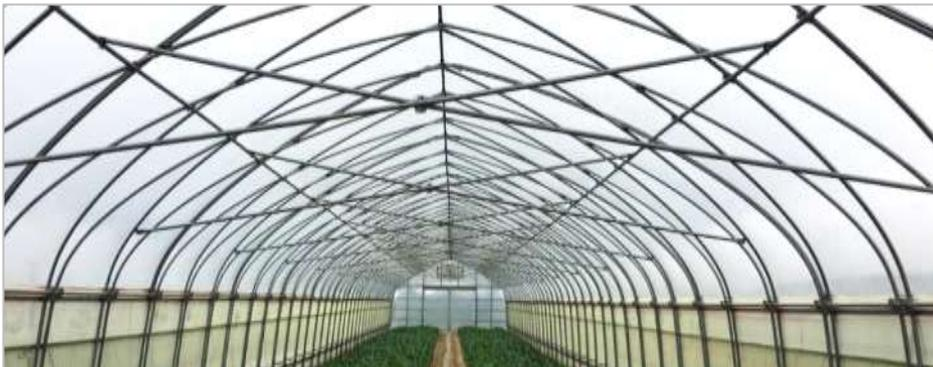
図31 間口 5.4m、パイプ径 25.4 mm、ピッチ 100 cm、トラス構造、X型斜材補強
