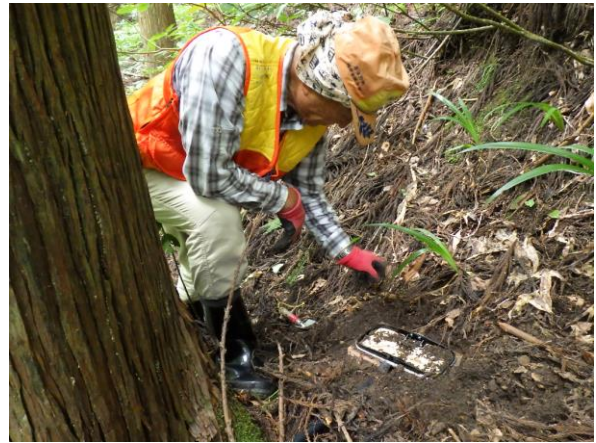
箱の上に踏み板を設置し、高さを地面と同じに調整する
