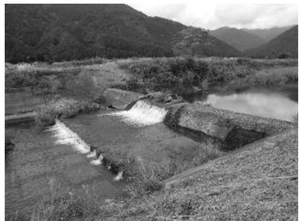
図2 岩屋川落差工
