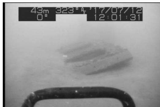
写真1-2 倒壊したドラゴンリーフ
