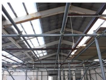
骨組みを作っているところ
