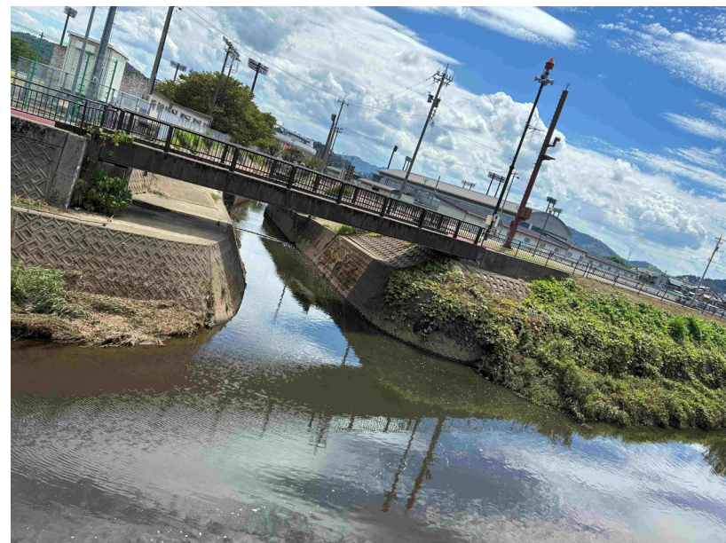
② 社雨水幹線と狐側合流点 9月2日11時撮影
