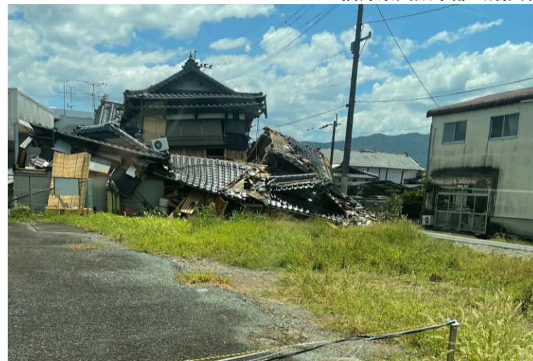
家屋の倒壊(氷川町)
