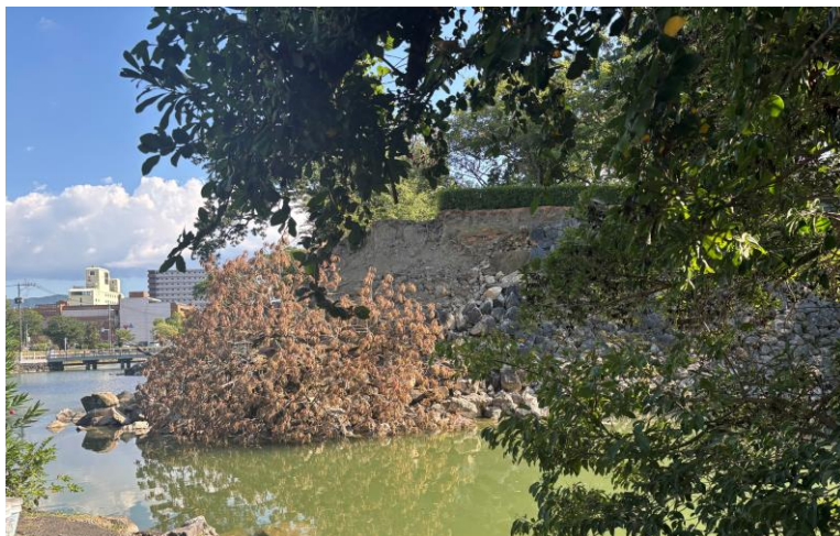
八代城の石垣の崩落
