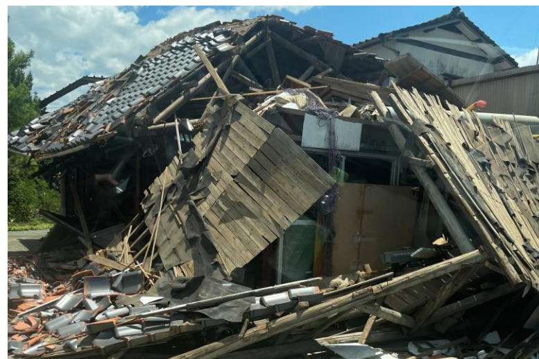
家屋の倒壊(氷川町)
