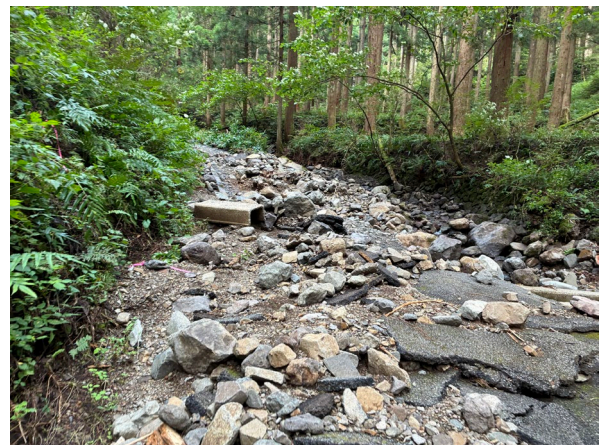
林道路面は石で覆われる
