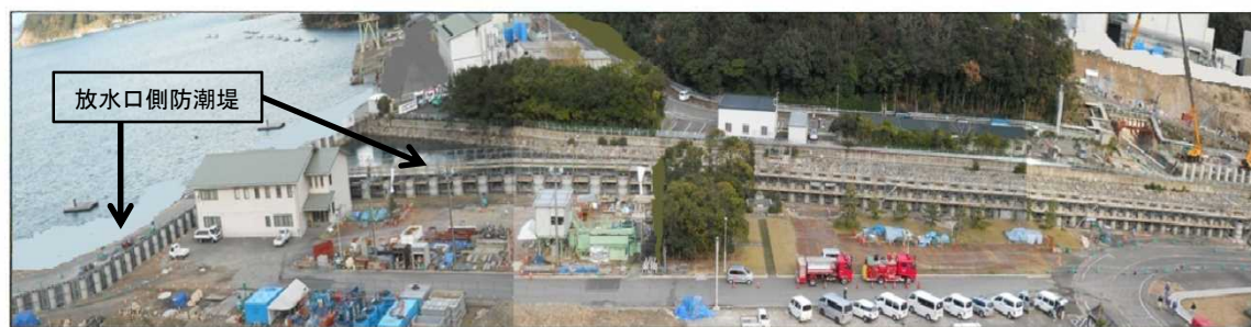
放水口側防潮堤
