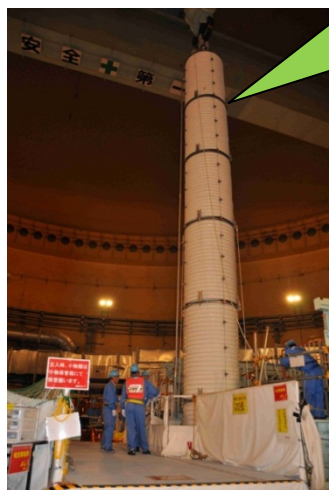
平成23年6月24日 炉内中継装置・燃料出入スリーブ一体引抜作業風景 (炉内中継装置・燃料出入スリーブは簡易キャスク内に収納)
