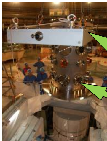
平成23年6月10日 可動式仕切板及び一体引抜用案内管据付作業風景
