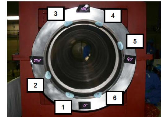
燃料出入孔スリーブ下端の圧痕
