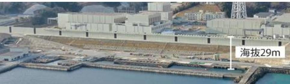
海拔29mの防潮堤設置。防潮堤の沈下防止・安定性向上のため、地盤改良等を実施。
