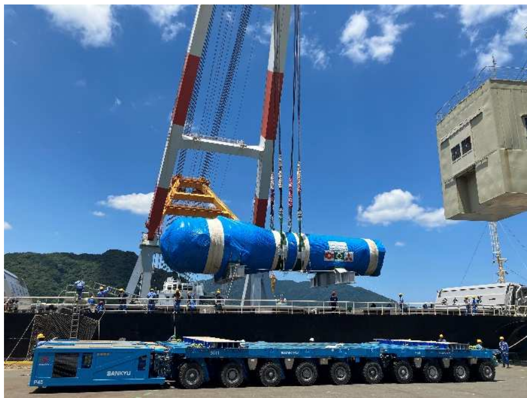
＜3号機 新蒸気発生器の陸揚げ＞
