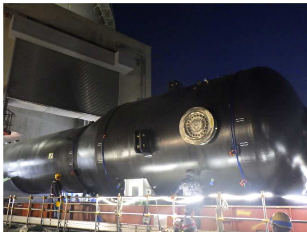
＜3号機 新蒸気発生器の格納容器への搬入＞
